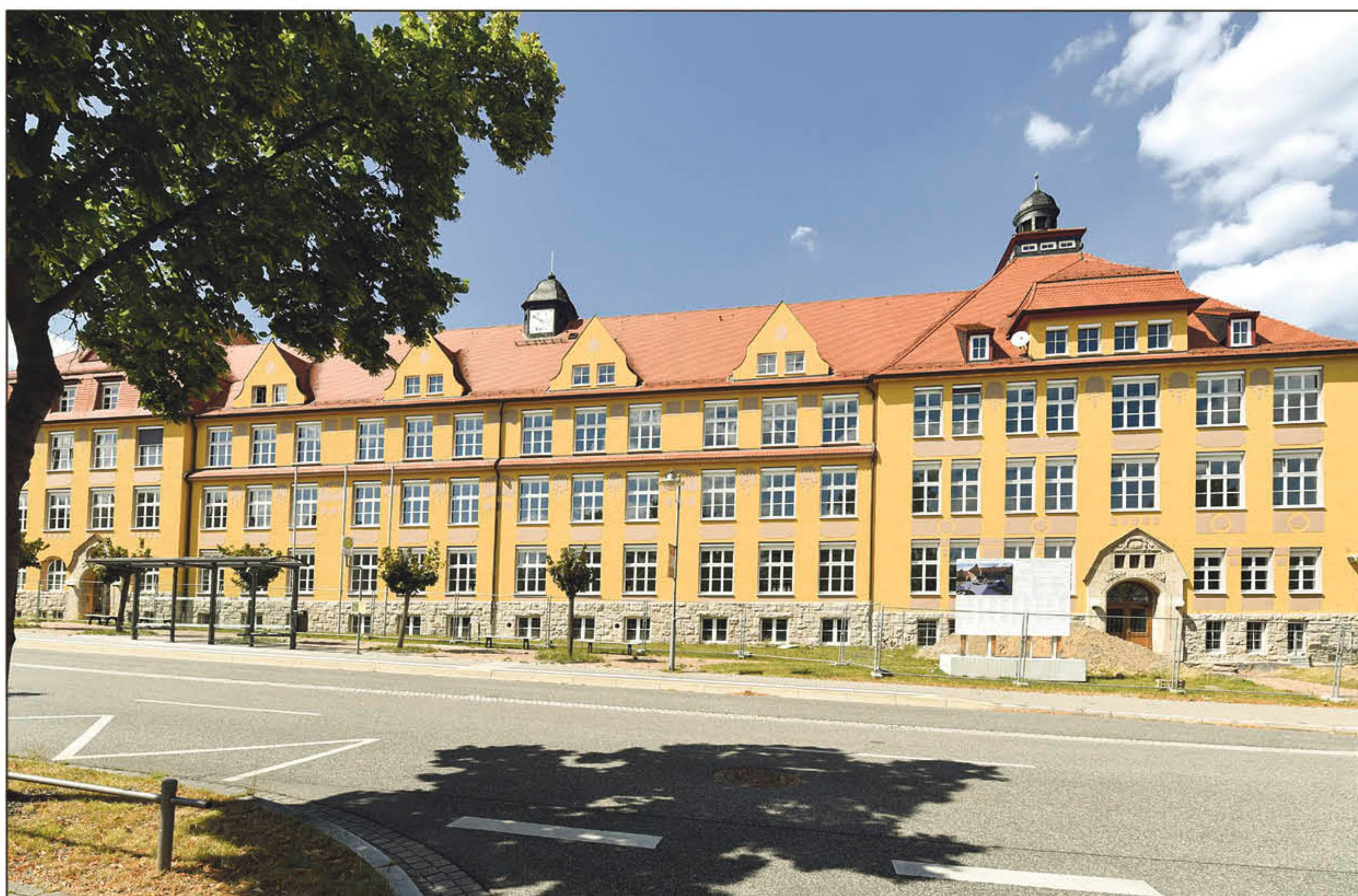
Es ist eines der größten Hochbauprojekte der Stadt Saalfeld/Saale der vergangenen Jahre. Für 7,5 Millionen Euro wird die Saalfelder Regelschule „Geschwister Scholl“ saniert.
