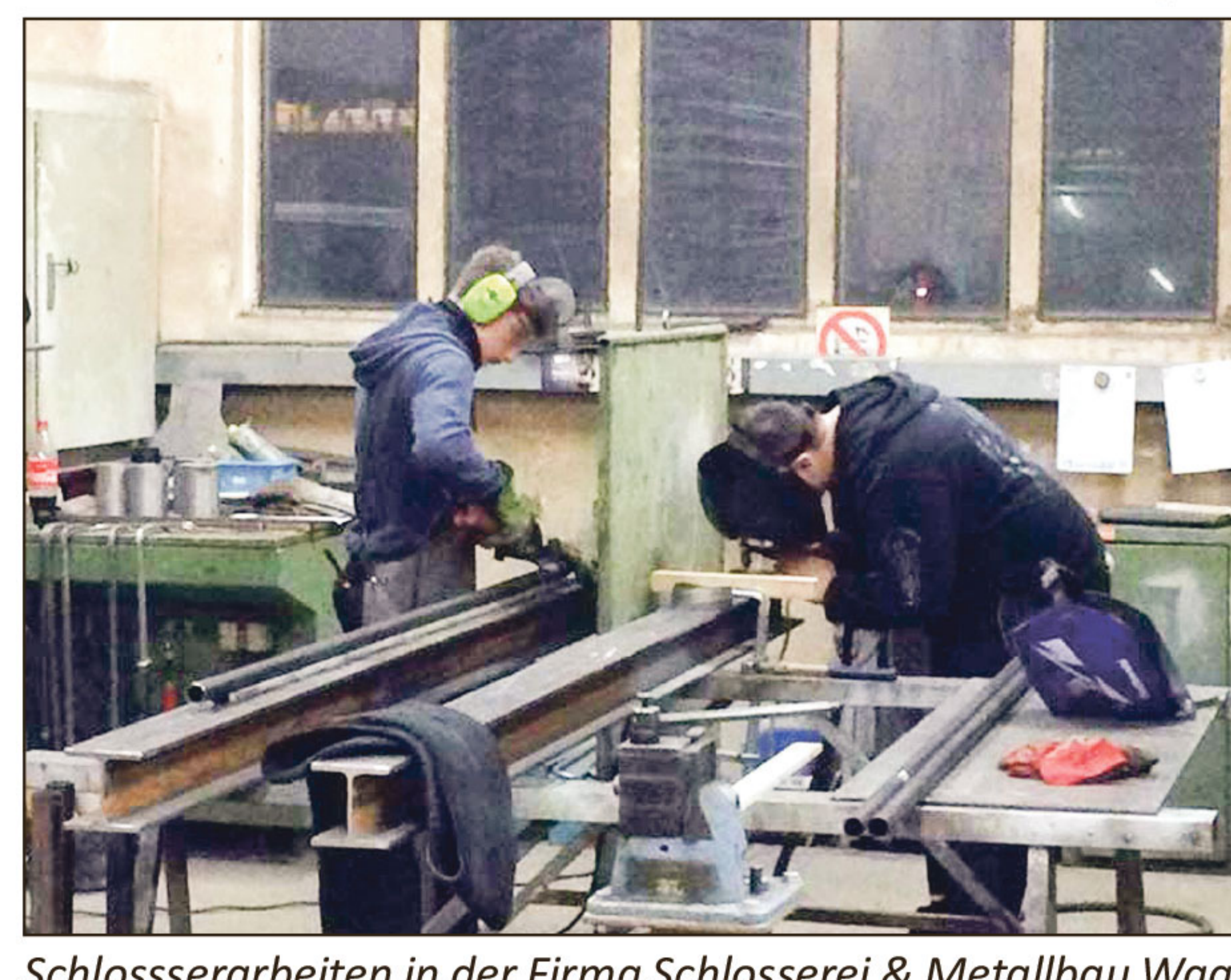
Schlosserarbeiten in der Firma Schlosserei & Metallbau Wagner.
