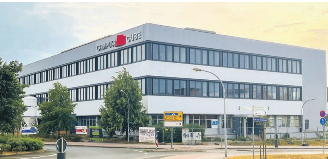
Der Innenausbau im Campus Cube Hermsdorf soll ab August abgeschlossen sein.
