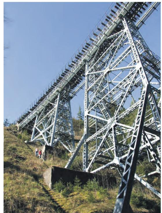
Die Ziemestabücke bei Remptendorf ist ein Viadukt der Bahnstrecke Triptis-Marxgrün in Thüringen, der zwischen 1893 und 1895 erbaut wurde. Sie führt über den Ziemesgrund zwischen Ziegenrück, Altenbeuthen und Remptendorf und gehört zur Gemeinde Remptendorf. Er ist eingeleigt, besteht vollständig aus Stahl, ist stillgelegt und steht unter Denkmalschutz.
