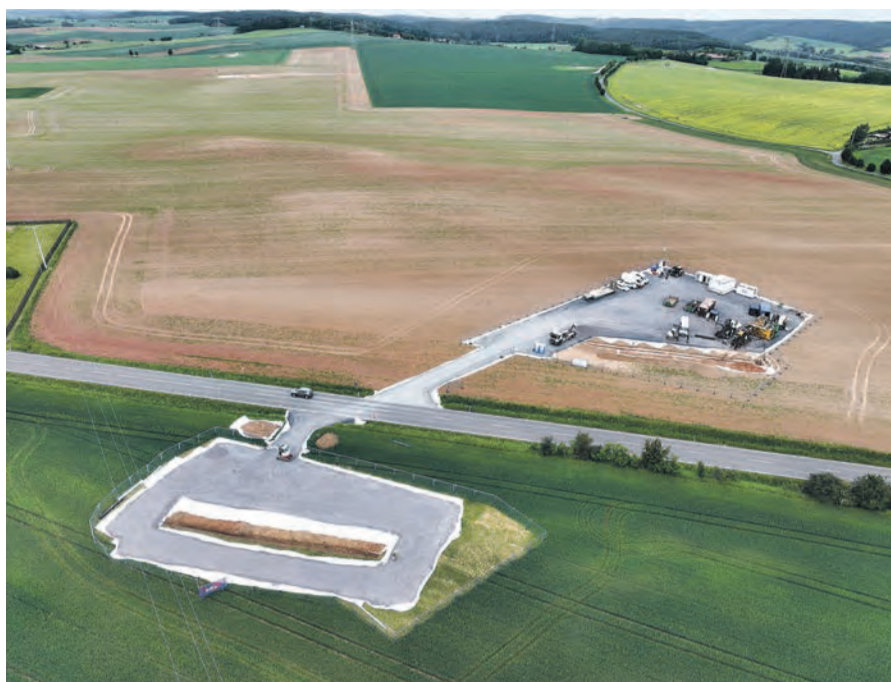
Vorgezogene Baumaßnahme an der B92 südwestlich des Wünschendorfer Ortsteils Zossen. Konkret handelt es sich dabei um eine Unterquerung im Spülbohrverfahren. Foto: 50Hertz
