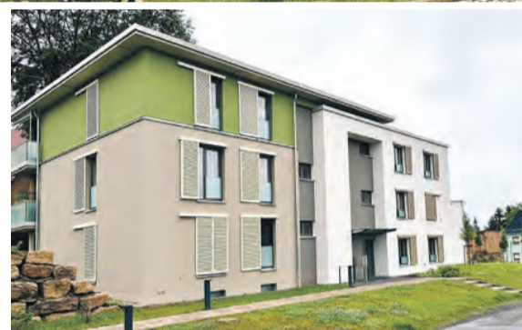
Fotos oben: Komplettte Innenarbeiten von 25 Wohneinheiten und Treppenhäusern in der Schillerstraße, 17, 17a, 19 in Triptis. Foto: Malerhof
