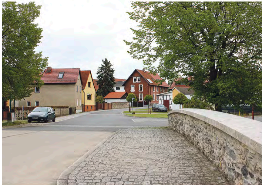
Die Brücke am Dorfplatz in Oppurg führt über das Flässchen Orla.
