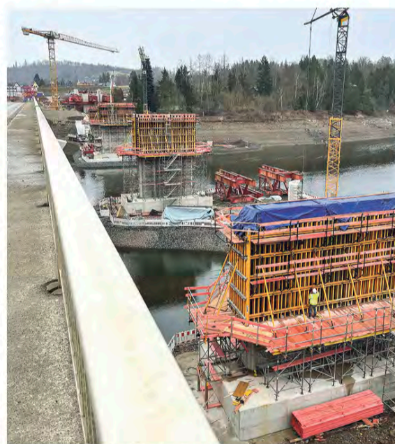
Brückenbau in Saaldorf mit umfangreicher Straßenumverlegung (Stand Febr. 2024, siehe Zeitung Teil 2 Titel). Foto: kl
