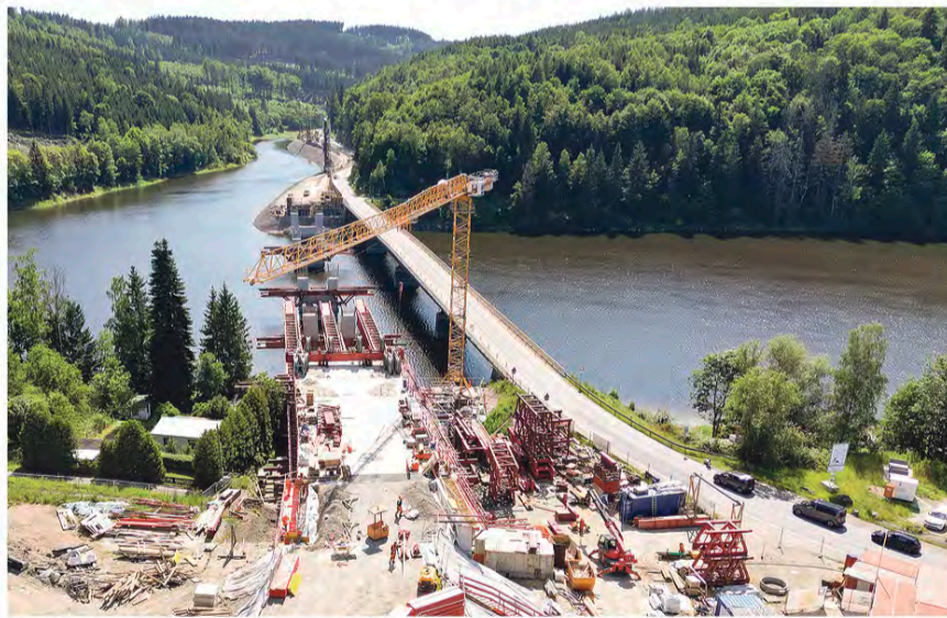
Die Baustelle der Stauseebrücke (Stand Juni 2024).
