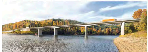
So soll es nach Fertigstellung der Brücke einmal aussehen.
