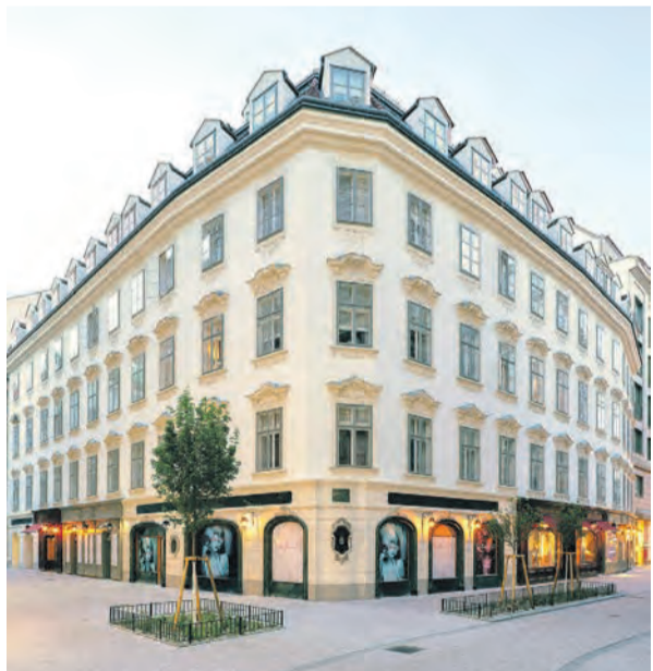
Direkt gegenüber des Wiener Stephansdoms liegt The Leo Grand, ein außergewöhnliches Hotel, das seine Gäste auf allen Zimmern mit einem Dusch-WC verwöhnt. Foto: djd-k/Geberit
