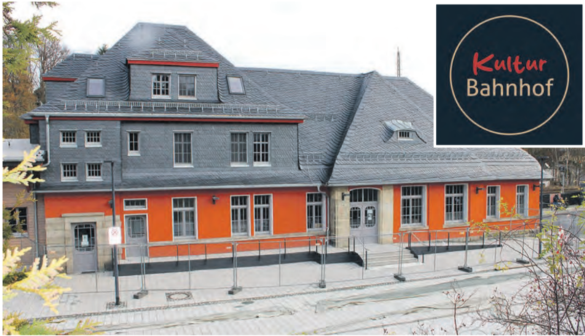
Nach umfangreicher Sanierung des Bahnhofsgebäudes in Bad Lobenstein findet am 6. Dezember um 15 Uhr die feierliche Eröffnung statt. Foto: ab
