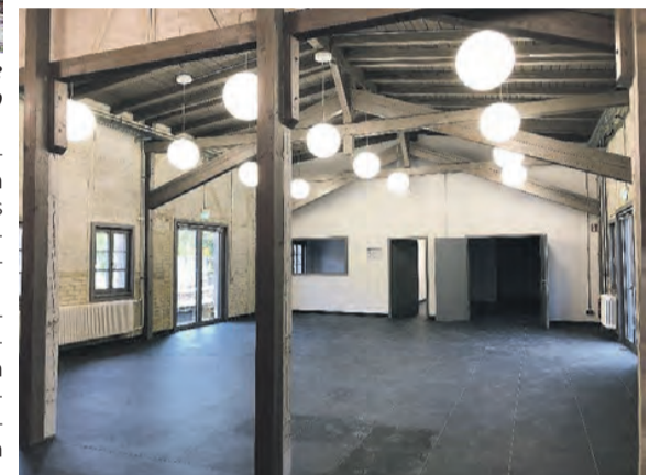
Bahnhofshalle während und nach der Sanierung. Fotos: Stadtbauamt Bad Lobenstein
