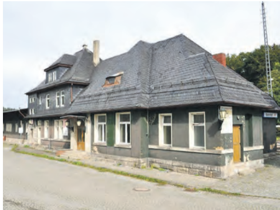
Der Anblick des Bahnhofs vor Baubeginn. Foto: Stadtbauamt Bad Lobenstein
