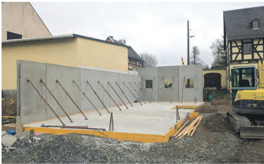
Der Neubau des Dorfgemeinschaftshauses in Rothenacker wurde 2024 begonnen.
