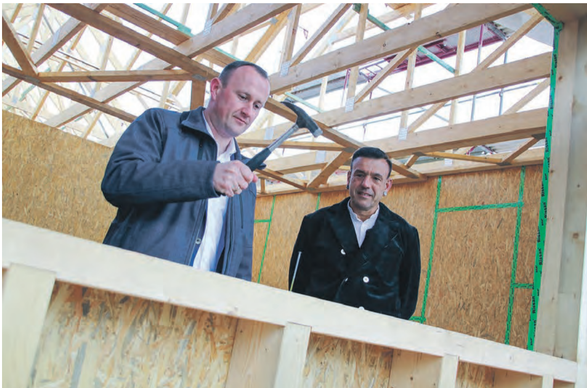
Am 25. April 2024 wurde das Richtfest für den Erweiterungsbau der Regelschule Schleiz gefeiert. Fotos: Alexander Hebenstreit
