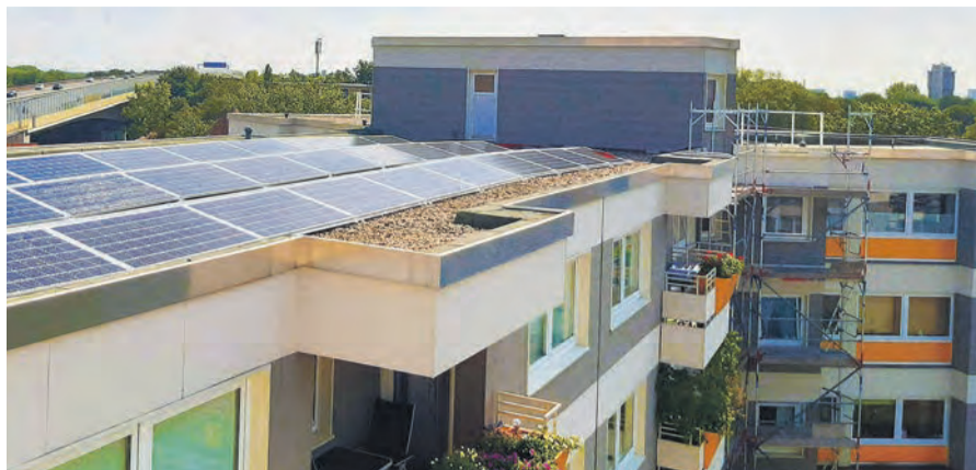
Mehrere Wohnungen in einem Gebäude nutzen gemeinsam Strom aus einer Photovoltaikanlage auf dem Dach: Das war bisher mit einigen bürokratischen Hürden verbunden. Abhilfe soll das Modell der gemeinschaftlichen Gebäudeversorgung schaffen. Foto: pixabay
