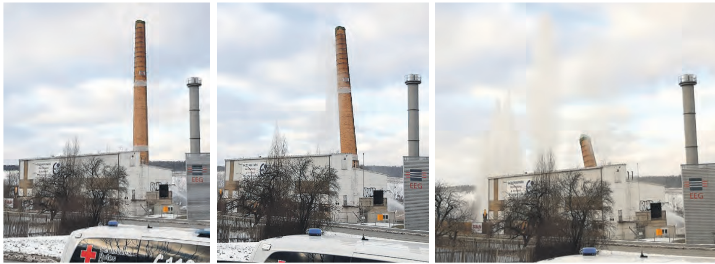
In wenigen Sekunden war alles vorbei: Letztes Foto vom Schornstein vor der Sprengung (oben links) – der Schornstein fällt (oben Mitte) – Wasserfontänen verursachen einen Sprühnebel gegen Staubbildung, während der Schornstein in sich zusammensackt (oben rechts). Zurück bleibt ein riesiger Schutthaufen (Foto unten, mit Vertretern der Bau- und der Abrissfirma sowie Landrat Johann Waschnewski – rechts). (Fotos: Landratsamt/Claudia Bioly)
