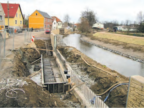
Bau des Hochwasserschutzes 2011 in Oppurg.
