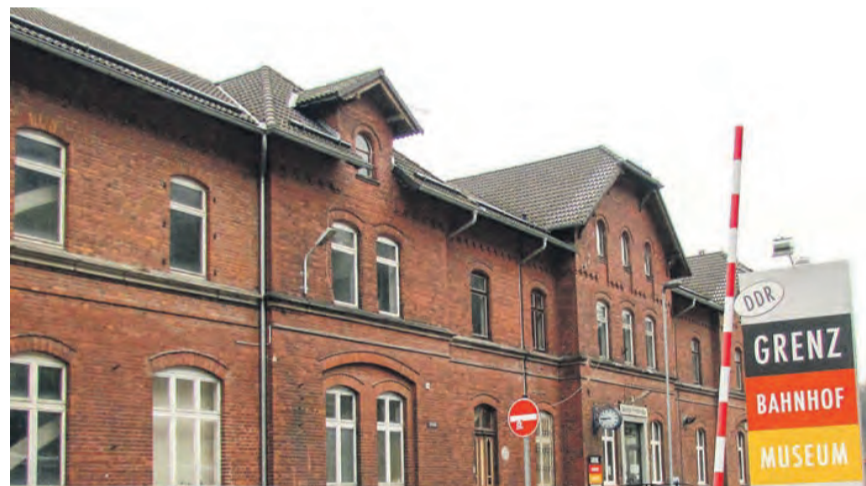
Im November 2010 eröffnete die Gemeinde Probstzella, in dem Gebäude des 1885 erbauten Bahnhofs, das Grenzbahnhofmuseum Probstzella. An folgenden Tagen im Jahr 2026 werden im Grenzbahnhofmuseum Probstzella Sonderöffnungen angeboten: 14. Mai 2026 – Christi Himmelfahrt, 17. Juni 2026 – Tag des Volksaufstandes, 3. Oktober 2026 – Tag der Deutschen Einheit. Öffnungszeiten: 13 bis 17 Uhr
