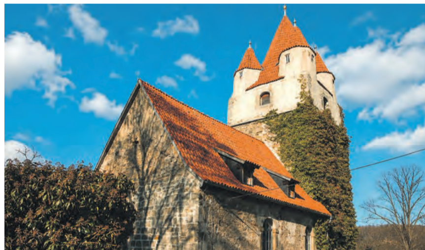
Die Wehrkirche St. Anna in Oberoppurg. Foto: wgv
