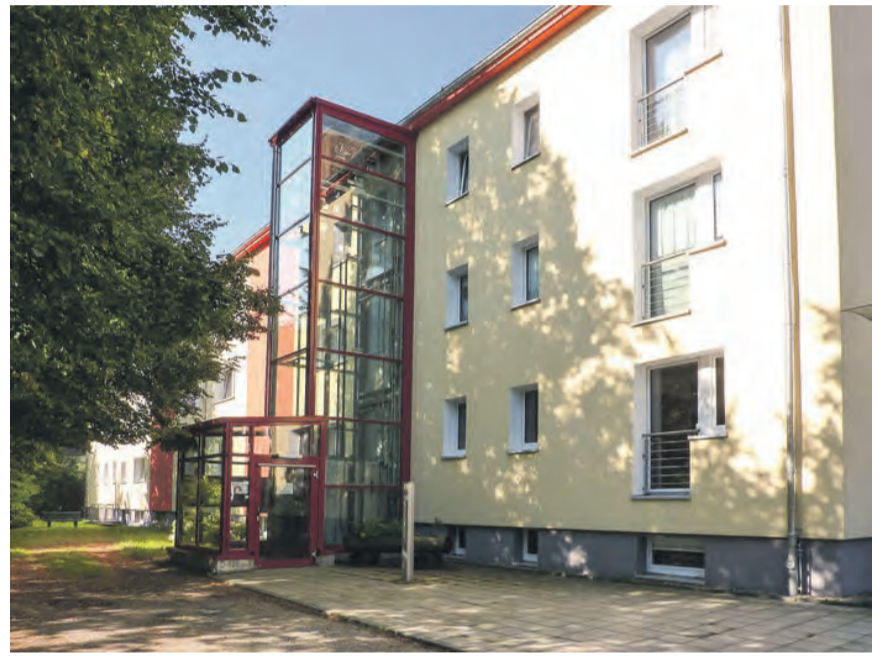
Baumgarten 20 mit angebautem Aufzug.
