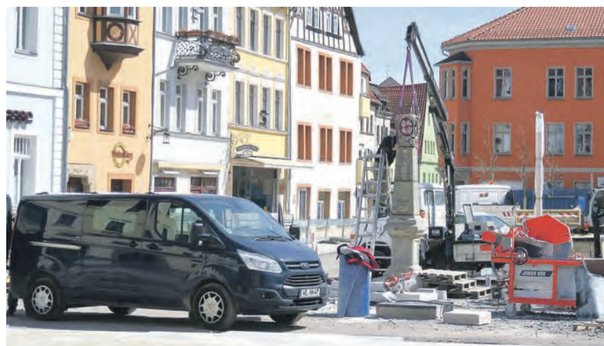
Im April setzte die Firma Wolf Natursteinarbeiten die Postmeilensäule fachgerecht an ihren neuen Platz.
