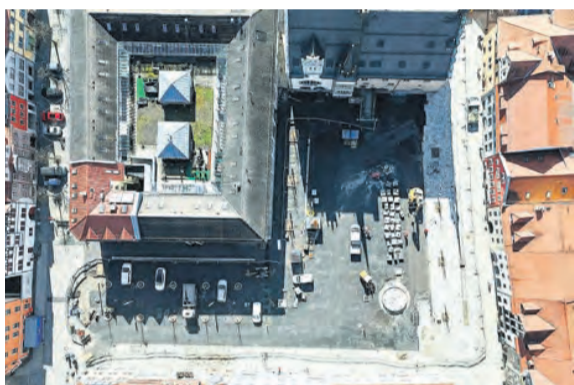
Luftbild der Baustelle vom 17.03.2026 Fotos: Stadt Neustadt
