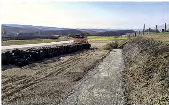
Eine Reihe an Baumaßnahmen – wie hier am Buchhübel – sollen die Kulturrennstrecke zu künftssicher aufstellen.
