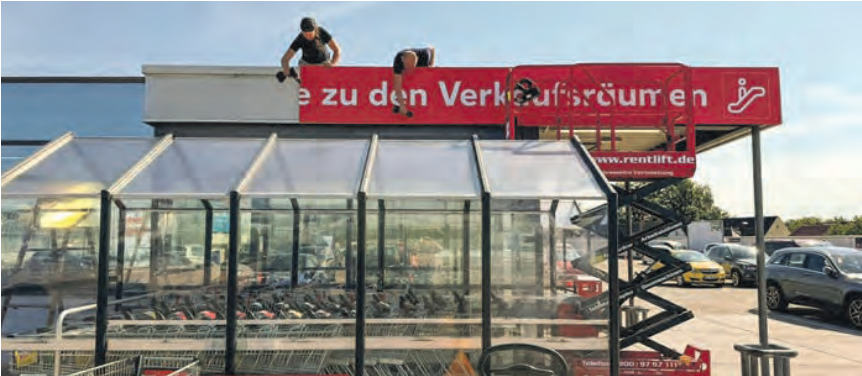
Anbringung von Werbetafeln – letzte Arbeiten vor Eröffnung des Marktes.
