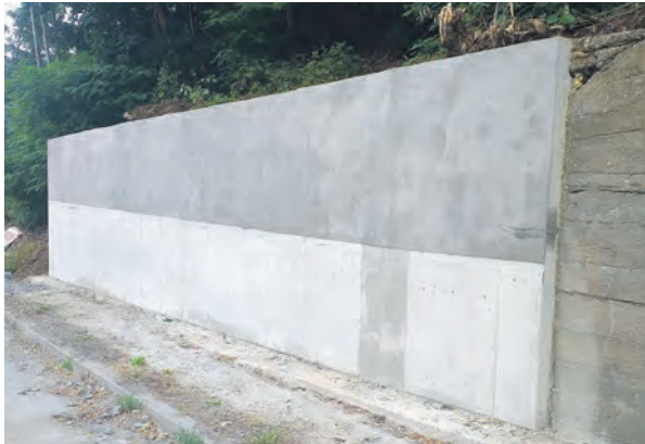
In Gräfenenthal ist die Notsicherung der Mauer abgeschlossen, Bauabnahme war am Mittwoch, 8. Juli. Fotos: Diana Soriano/Laura Sarbu/Kai Sommer
