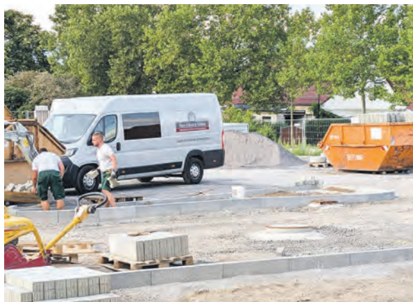
Noch im Bau – der Parkplatz.
